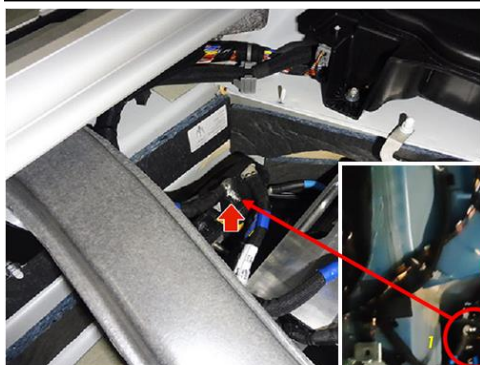
バッテリー切断ユニットからの48V接点
